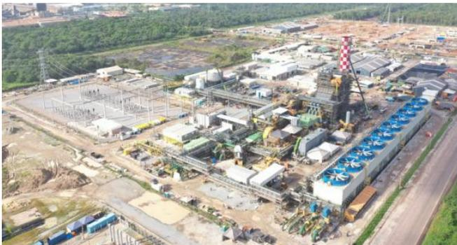
***A usina conta com uma unidade geradora no modelo single-sha, tecnologia em que a turbina a gás natural e a turbina a vapor estão conectadas ao eixo de um único gerador***
