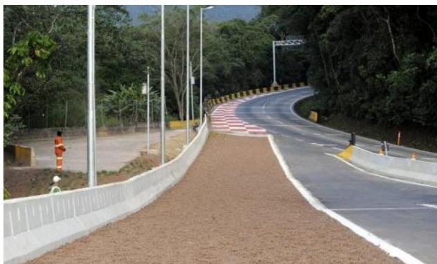
*A nova rampa contará com 200 metros de extensão e 5 metros de largura, incluindo um reservatório de argila expandida com 90 metros de comprimento*
