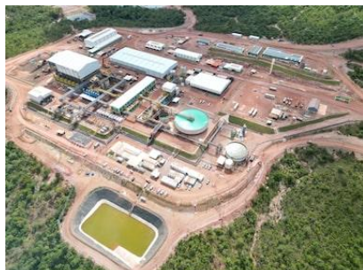
Instalações de beneficiamento de óxidos de terras raras em Minaçu (GO), da Mineração Serra Verde Foto: Divulgação/Mineração Serra Verde
