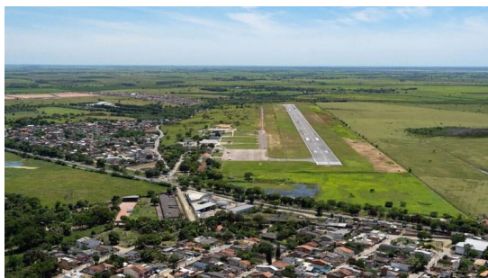
Aeroporto de Campos dos Goytacazes (RJ) – Foto: Grupo Infra
