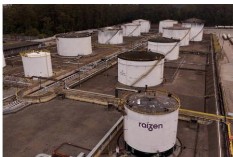
Tanques de combustível no interior de um Terminal de Distribuição da Raízen em São Paulo, Brasil - Amanda Perobelli -20.ago.25/Reuters
