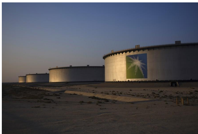
Tanques de armazenamento de petróleo da Saudi Aramco em Ras Tanura, Arábia Saudita — Foto: Simon Dawson/Bloomberg
