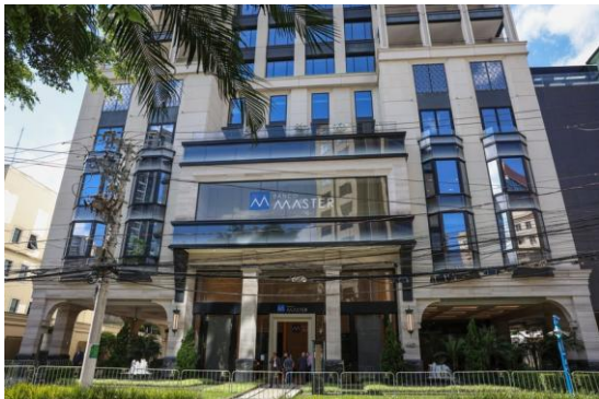
Fachada do Banco Master em São Paulo — Foto: Rovena Rosa/Agência Brasil/20/11/2025
