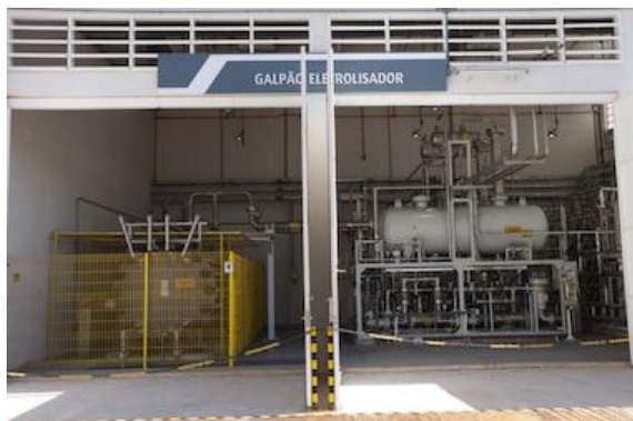
Equipamentos que separam as moléculas de hidrogênio da água na fábrica em Jacareí (SP) Foto: Tiago Queiroz/Estadão
