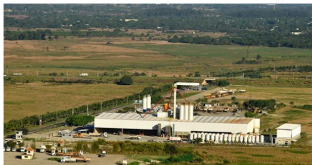
Fábrica de argamassa da Santa Luzia em Itaguaí (RJ) — Foto: Reprodução/Site Santa Luzia
