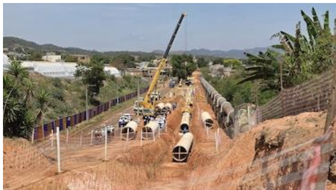
Obras da Copasa na região metropolitana de Belo Horizonte, Minas Gerais. Copasa/DIVULGAÇÃO Foto: Copasa/Divulgação
