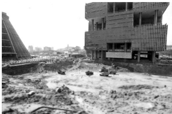
Catedral Metropolitana e edifício sede da Petrobras ainda em obras — Foto: Luiz Pinto/ 12.01.1973
