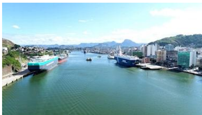
Vista geral das instalações do complexo portuário Vitória e Vila Velha (ES), operado pela VPorts Foto: VPorts/Divulgação
