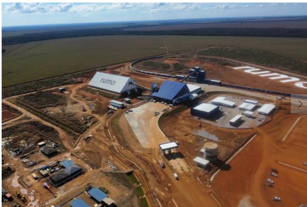
Novo terminal da BR-070 em Dom Aquino, no interior de Mato Grosso Divulgação/Rumo
