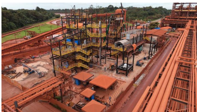
Unidade semi-industrial de processamento de resíduos de alumina, da New Wave, está em fase de instalação em Barcarena (PA) Foto: New Wave/Divulgação
