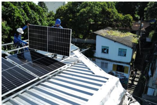
Painéis solares sendo instalados em um telhado no Rio de Janeiro — Foto: Bloomberg
