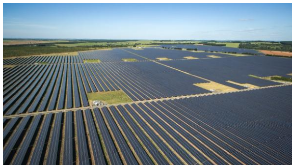
Módulos fotovoltaicos em uma usina solar da AES Tietê S.A. em Guaimbê, no estado de São Paulo — Foto: Bloomberg
