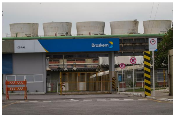
Entrada principal da Braskem em Maceió, Alagoas Foto: Joédson Alves/Agência Brasil
