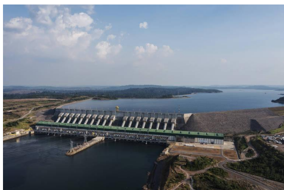
Barragem da casa de força principal da hidrelétrica de Belo Monte, no rio Xingu, em Altamira (PA) - Lalo de Almeida - 17.ago.22/Folhapress
