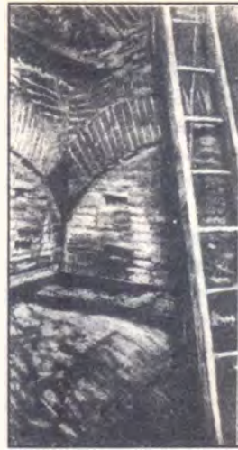
Las cámaras del mercado del Norte y la estructura de ladrillos de las bóvedas de cierre, mostrando la estructura constructiva y su forma (La vida moderna, 1909).
