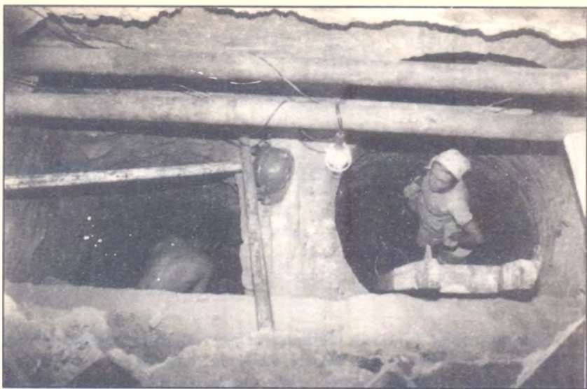
Excavación de los aljibes del Museo Histórico Nacional en 1988, en Parque Lezama, obra típica del siglo pasado.
