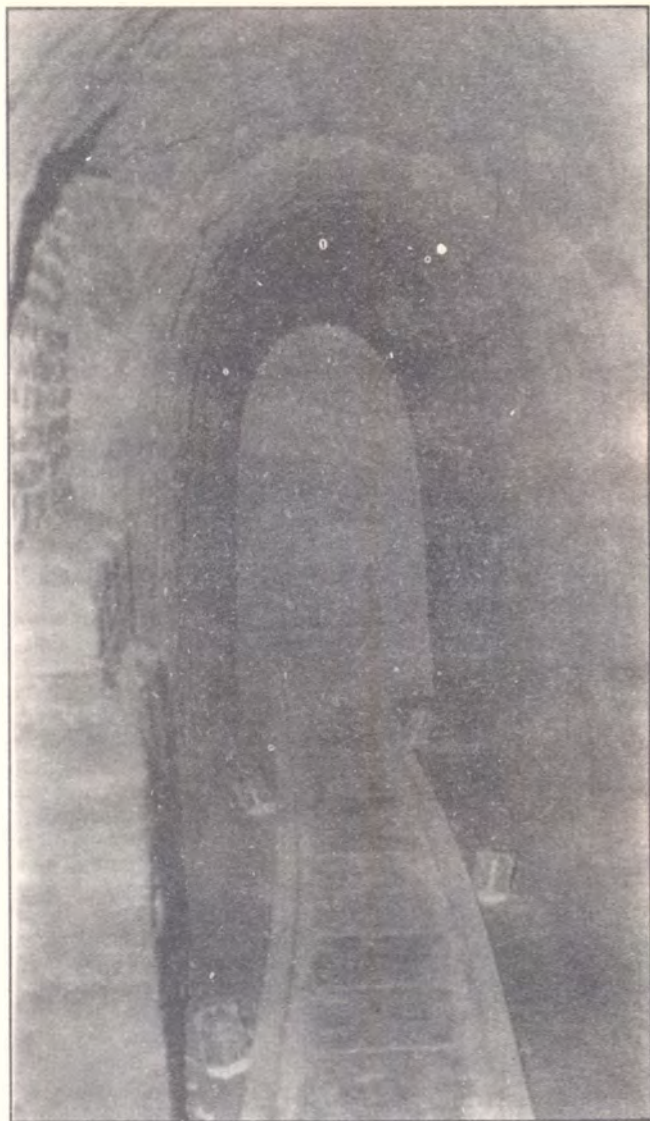
Una de las galerías de la Manzana de las Luces desde el corte de un cimiento hasta su intersección con otro tramo perpendicular (Revista Cabal).
