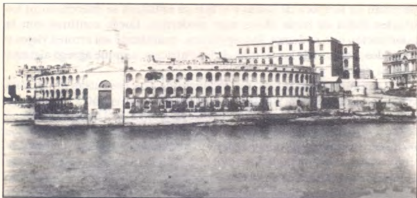
La Aduana Nueva construida por Taylor: a su izquierda se ve el túnel curvo que conducía hacia la Playa de Maniobras, sistema de acceso original y por cierto único en su época (Archivo General de la Nación)
