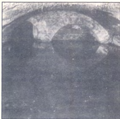
Otro sector del túnel del Tercero del Sur en el lugar de bifurcación de su bóveda en la calle Chile; aún permanecía inundado en 1960 (Archivo La Prensa).
