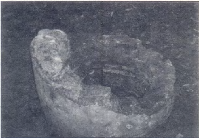
El pozo central del túnel de Castelforte; servía para el agua de un molino y a su vez comunica con otro túnel más profundo, obra del Ingeniero Canale en 1872/4.
