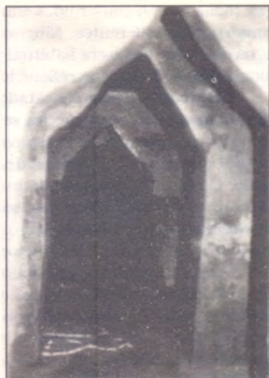
Dos tipos de arcadas de altura reducida en el interior del peculiar aljibe de la Casa de la Cultura de Avellaneda, con un sector aún tapiado.
