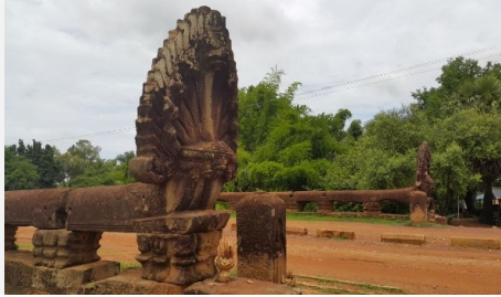
Pont du Naga
