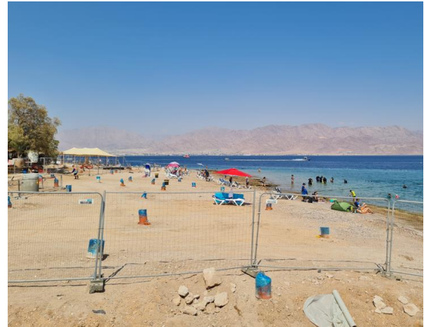
חוף אלמוג: שרוולי תשתית (חלקם כולל ככל הנראה גם חשמל לתאורה) לשמשיות בקרבה לקו המים, 1.7.2022
