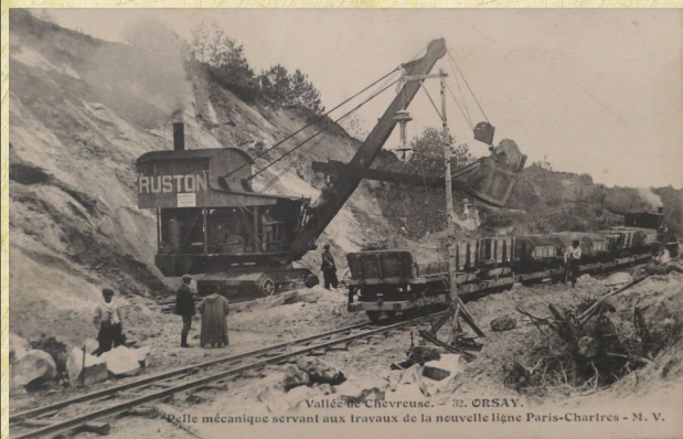
Vallée de Chevreuse - Orsay - Pelle mécanique servant aux travaux de la nouvelle ligne Paris Chartres
