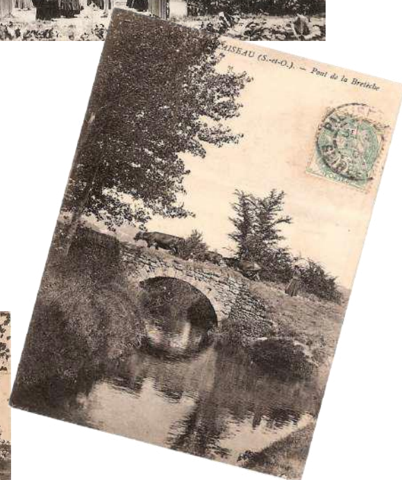
Pont de la Bretèche
