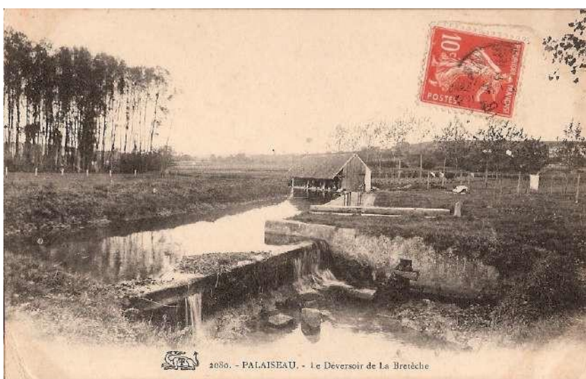
Déversoir de la Bretèche
