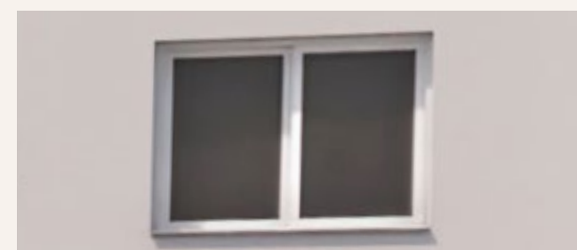
Esquadrias de dormitórios em alumínio e pintura eletroestática
