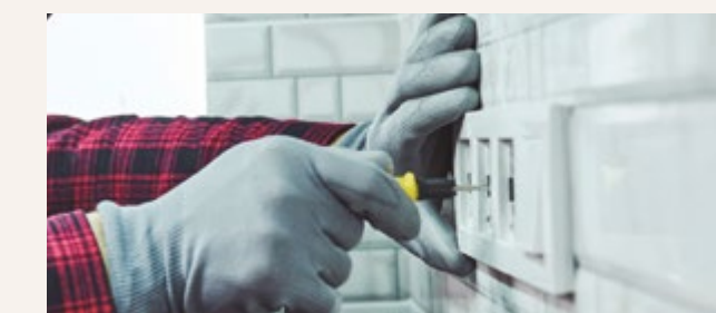
Utilização de materiais elétricos e hidráulicos de empresas referências de mercado
