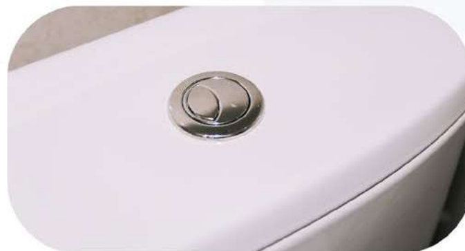
Sistema dual flush nos vasos sanitários
