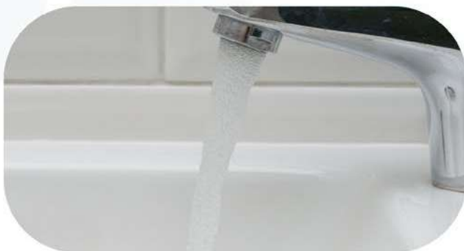
Arejadores nas torneiras dos apartamentos e áreas comuns
