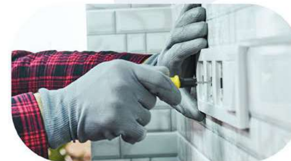
Materiais elétricos e hidráulicos de empresas referência de mercado
