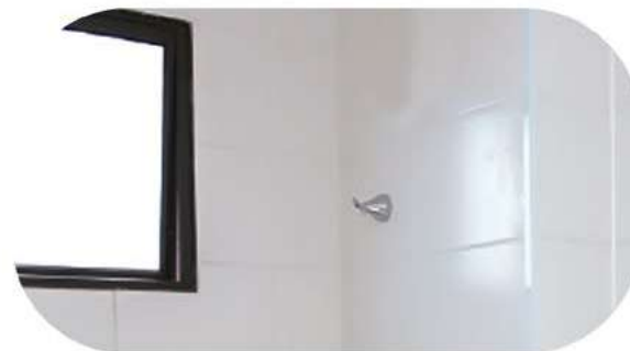
Banheiro com área do box 100% revestida com cerâmica
