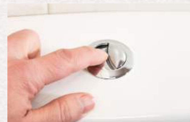
Sistema Dual Flush nos vasos sanitários
