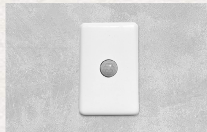
Sensores de presença nas áreas comuns
