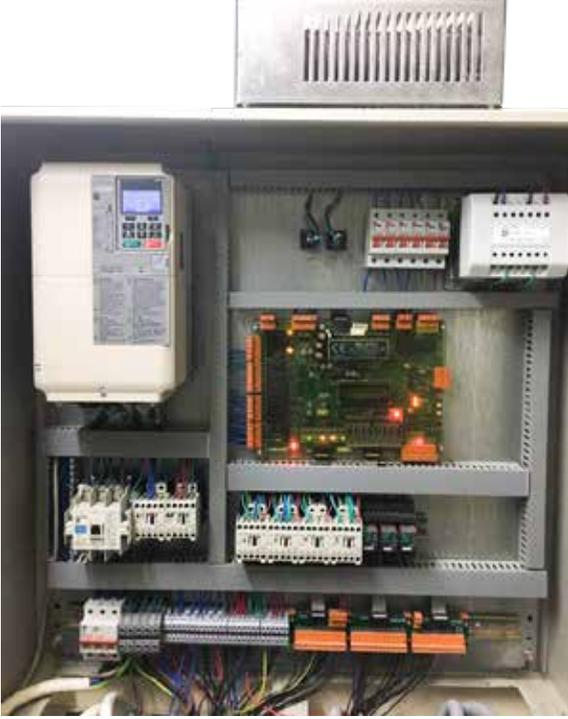
1- أجهزة تحكم ميكروبروسيسور مفردة ومزدوجة : أكثر من 10 سنة خبرة في أجهزة التحكم ميكروبروسيسور، نظام التشغيل ذو السرعتين الذي يعمل بالتيار المتردد حتى 1,00 م/ث وكذلك نظام التشغيل المجهز بـ ٧٧٧ف حتى ٢م/ث وهذه الأجهزة قابلة تماماً للبرمجة في الموقع حسب الإحتياجات المحددة للتركيب، لاتدعو الحاجة إلى تعديلات إضافية من الجهة الصانعة أجهزة التعامل معها بسيطة جداً هناك ٣ أنواع مختلفة وتغطي نطاق الجهاز جميع أنواع تركيب المفردة والمزدوجة والثلاثية وغيرها .
