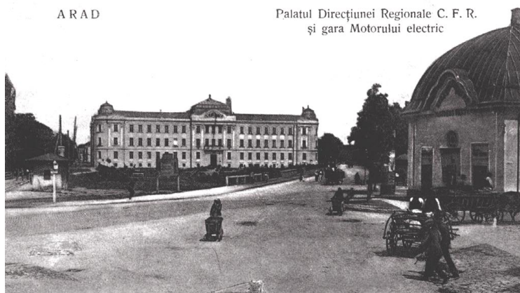
Cele două clădiri feroviare emblematice ale Aradului: Gara electrică construită în 1906 și Palatul Direcțiunii Regionale de Căi Ferate, inaugurat în 1913
