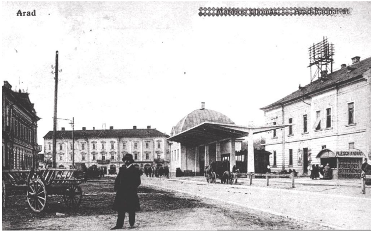
Clădirea cu peroane și cupolă a stației terminus a trenului electric pe Calea Radnei (azi Bd. Iuliu Maniu)
