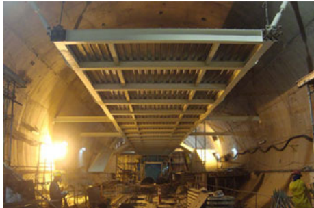
Figura 3 - Mezanino em execução
