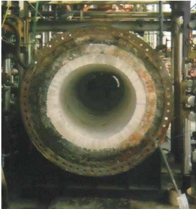
Ladrillos de Ref-Mull en un Reactor para la fabricación de negro de Humo
