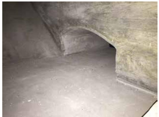
A través de una proyección neumática, nuestros productos, proporcionan un método rápido de instalación. Una estructura Refractaria instalada a través de una buena proyección, da por resultado operaciones más largas, incrementa la productividad y baja el costo total del Refractario.
