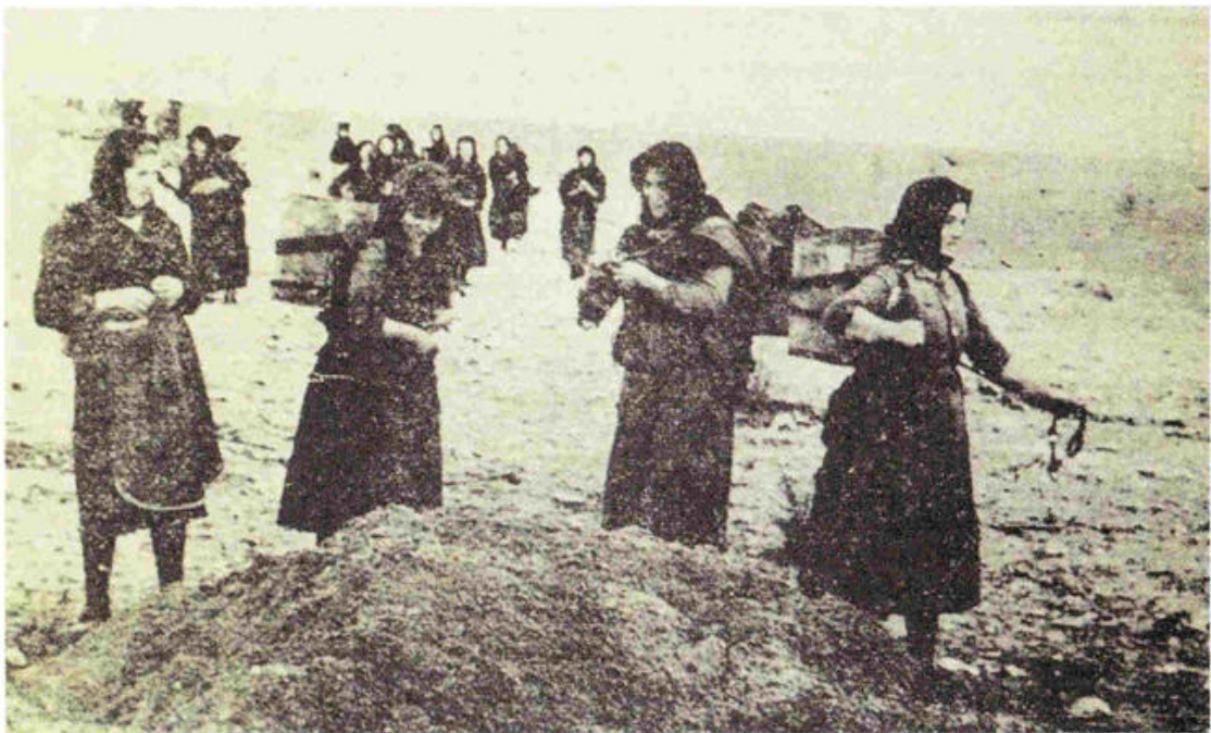
Ἡπειρώτισσαι, αἱ ὁποῖαι, ἀφοῦ μετέφερον πυρομαχικά, συνεχίζουν μεταφέ- ρουνσαι ἄμμον διὰ τὴν ἐπισκευὴν τῶν ὁδῶν.
