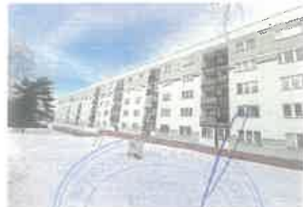
Widok na budynek od strony północno-wschodniej. Widok na część budynku od strony północno-zachodniej.
