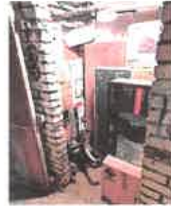
Pomieszczenie przynależne do lokalu w piwnicy.
