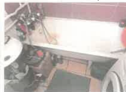
Widok na łazienkę z wc.
