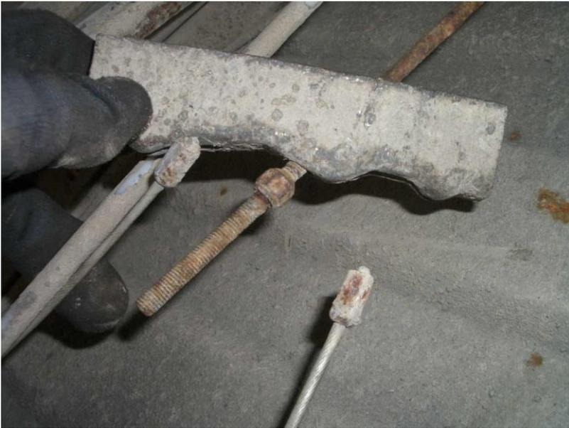
Wir reinigen den Bereich, an dem wir die Platte befestigen wollen, gut, mit einer Drahtbürste, Schleifpapier, Meißel, falls Rost vorhanden ist ... was auch immer nötig ist, damit sie gut sitzt.
