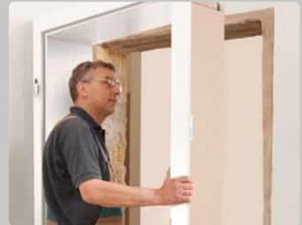
Die Tapete wird um die Bekleidung herum sauber eingeschnitten. Mit einem Stecheisen wird die Zierbekleidung von der Zarge gedrückt und das Futterbrett der Zarge im unteren Drittel mit einem sauberen Schnitt durchgesägt. Danach lässt sich die Zarge problemlos ausbauen. Bei der gesamten Demontage fällt kein nennenswerter Schmutz an, da keine Stemmarbeiten oder Ähnliches erforderlich sind.
