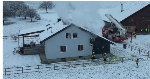
Bild 3: Brand in Hausfassade und Dachstuhl
