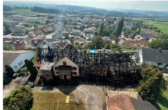
Bild 7: August 2023, Zuzwil, Brand Liegenschaft
