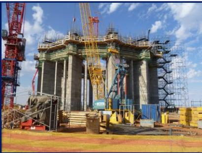
Una vez deslizado los dos primeros metros es recomendable utilizar siempre un hormigón con capacidad de retardo de fraguado de 10hrs (aprox.), ya que se debe ir a una baja velocidad, para dar tiempo a poner todo el sistema apunto, incluyendo los medios
