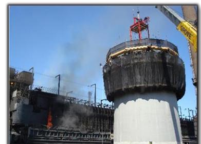
la estructura o castillete (Fig.3/Posic.6) soporte del sistema de transporte vertical de personas y materiales, podrá apoyar sobre la estructura de la plataforma superior.
