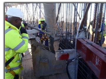
El vertido del hormigón debe realizarse en capas o tongadas regulares y completas de 25cm ( $\pm$  5 cm). No es recomendable colmar el molde, ni acumular montones en el mismo. El hormigón debe ser compactado por vibración inmediatamente después de ser vertido en el encofrado.
