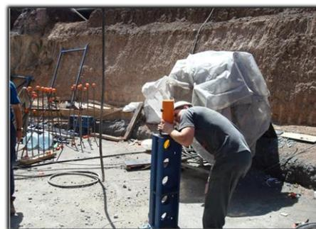
CONTROL DE VERTICALIDAD – APOYOS EN BASE PARA EQUIPOS ÓPTICOS O LASER
