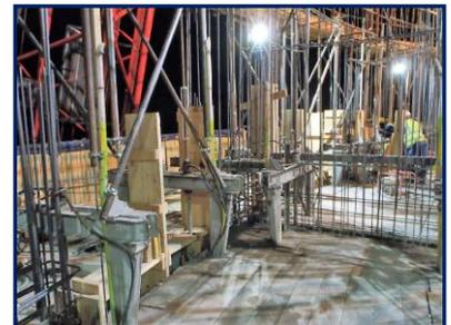
Todos los huecos y aperturas, así como, las placas de anclaje, deben ir fijados al refuerzo original o a barras de refuerzo suplementarias, con el fin de garantizar que se mantiene la posición correcta durante las tareas del deslizamiento.
