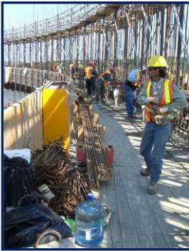
Habitualmente se instala en construcciones con mucho diámetro o superficie interior para minimizar costes y peso estructural. Estará situada a la altura del borde superior del encofrado. Desde ella se podrán realizar las operaciones de colocación del hormigón, vibrado del mismo, montaje de armaduras horizontales y verticales (estas últimas solo en el supuesto de no contar con plataforma superior), así como, maniobras de manejo y control del encofrado deslizante.
