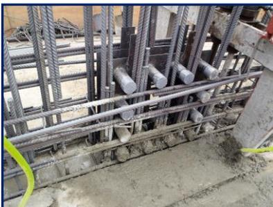
Todos los embebidos en los muros deben quedar anclados a las armaduras, para evitar desplazamientos o levantamientos por el molde.
