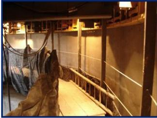
Estará situada por debajo del borde inferior del encofrado, en ella se realizarán las operaciones de acabado de paramentos, curado de los mismos y vigilancia del hormigón a la salida del molde.
