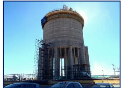
para el transporte vertical de personas y materiales, y poder montar las plataformas inferiores o colgantes después de transcurridos estos primeros metros. Una vez superada la primera semana del deslizamiento, se alcanzará en condiciones normales la velocidad normal, utilizando hormigón con capacidad de retardo de fraguado de 4hrs (aprox.), el cual proporciona un buen rendimiento al sistema, garantizando, además, el tiempo necesario para las de armaduras, control del encofrado
