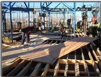
Estará situada a la altura del borde superior del encofrado. Desde ella se podrán realizar las operaciones de colocación del hormigón, vibrado del mismo, montaje de armaduras horizontales, así como, maniobras de manejo y control del encofrado deslizante. Habitualmente también soporta la estructura o castillete, para los reenvíos del sistema de transporte vertical de personas y materiales por el interior de la construcción.
