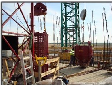
Estará situada en la parte superior del sistema del encofrado deslizante. Desde ella se realizarán las operaciones de extracción y nuevo montaje de las barras de trepada, recepción del hormigón y colocación del mismo por tolvas y trompas de elefante que conectarán con el molde en la plataforma intermedia o principal, montaje de armaduras verticales, sirviendo también de forma general, como zona de acopios de materiales.
