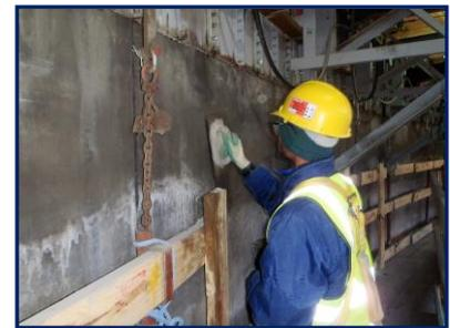
El curado del hormigón es muy importante en el proceso final del fraguado del mismo, evitando el resecamiento prematuro y por lo tanto la reducción de resistencia, así como, posibles fisuraciones por secado rápido.
