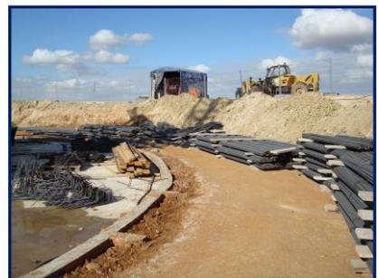
El almacenamiento general de las armaduras se realizará al pie de la construcción, desde donde se distribuirán a la plataforma de trabajo superior o a la plataforma principal del encofrado deslizante.
