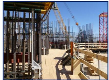
La longitud máxima de las armaduras verticales será de 6,0m.
