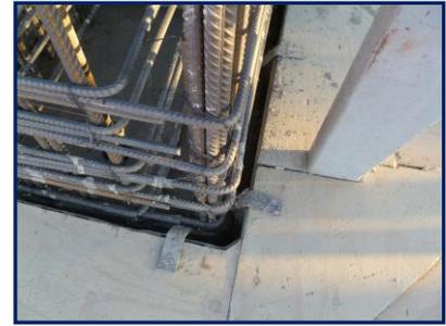
Las armaduras verticales deben ser guiadas para facilitar y asegurar su buen montaje, debiéndose instalarse una rejilla guía por encima de todo el perímetro del molde, a la altura del nivel de la plataforma superior.
