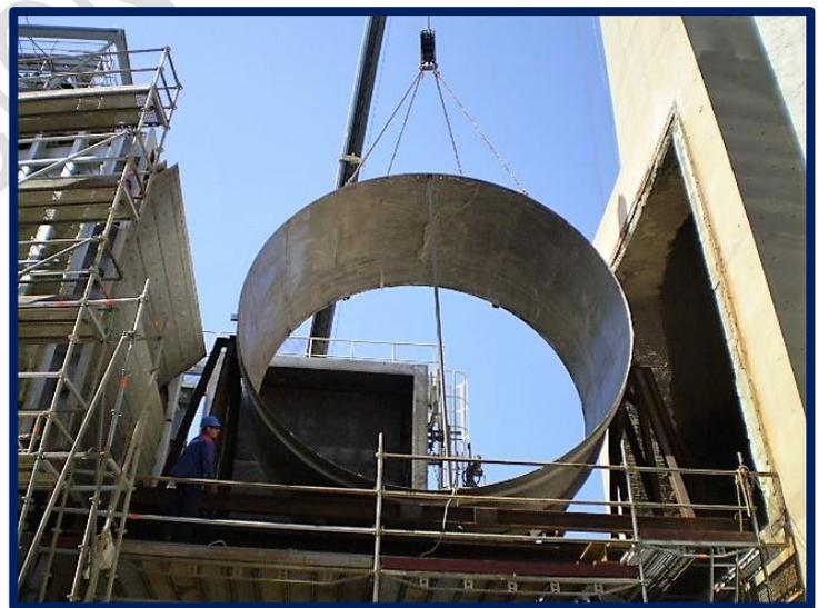
*Introducción al Interior de Chimenea, Volteo 90° y Montaje 1ª Virola*
