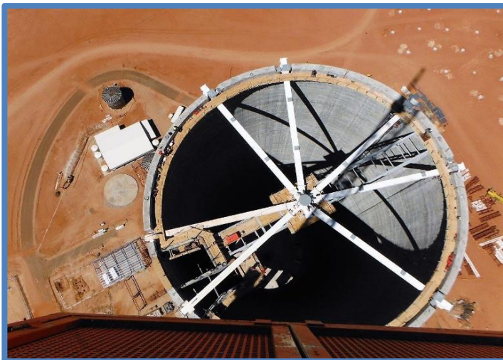
Montaje del Núcleo Central + Estructura “Araña”
