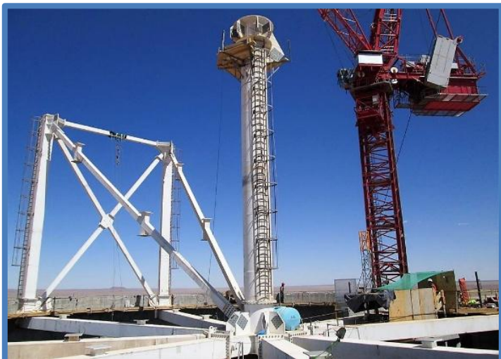
Montaje del Núcleo Central + Estructura “Araña”
