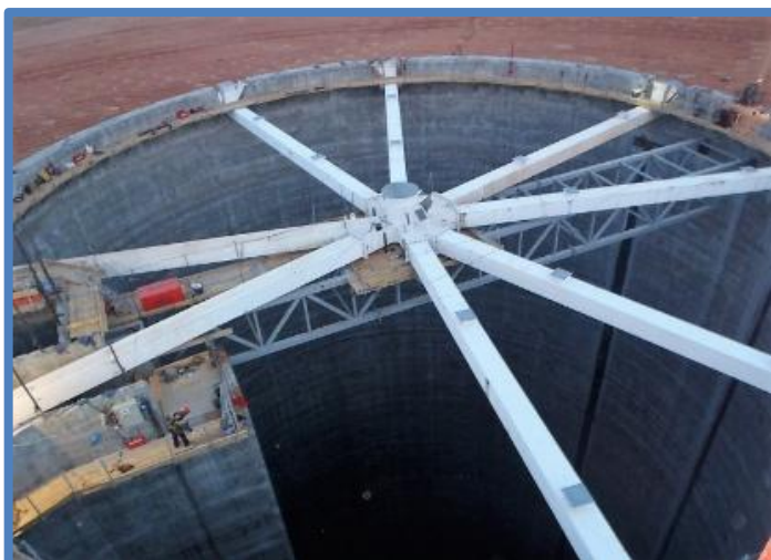
Montaje del Núcleo Central + Estructura “Araña”
