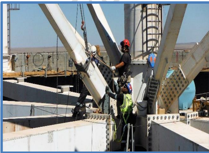
Montaje del Núcleo Central + Estructura “Araña”
